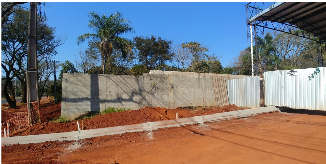
Figura 1: Foto do local para execução da Obra de Arte, em 30 de agosto de 2019.
