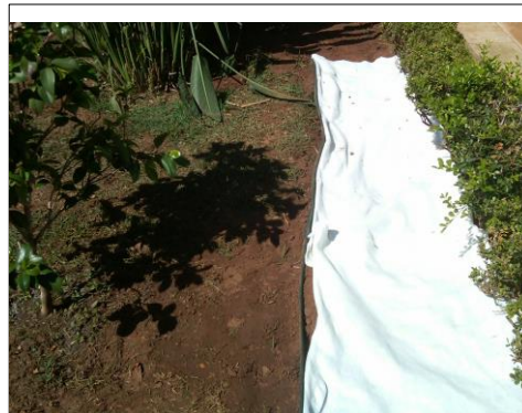
Figura 17: Manta de drenagem
