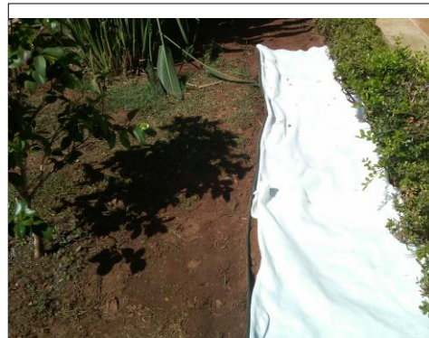
Figura 17: Manta de drenagem
