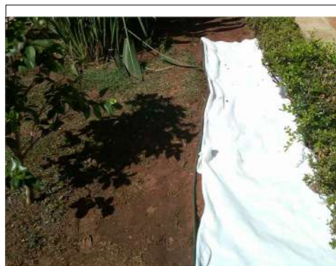
Figura 19: Manta de drenagem
