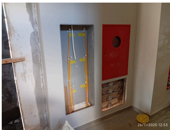
Foto 15 - Central de gás e hidrômetros individuais inacabados
