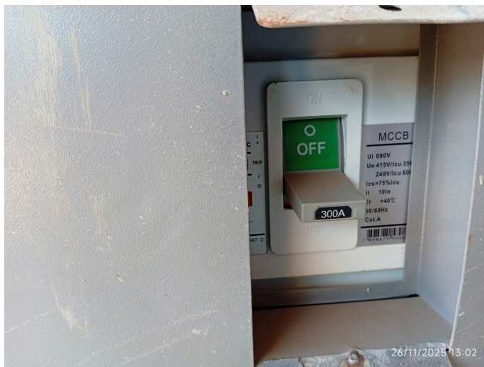
Foto 12 - Foto do disjuntor geral
