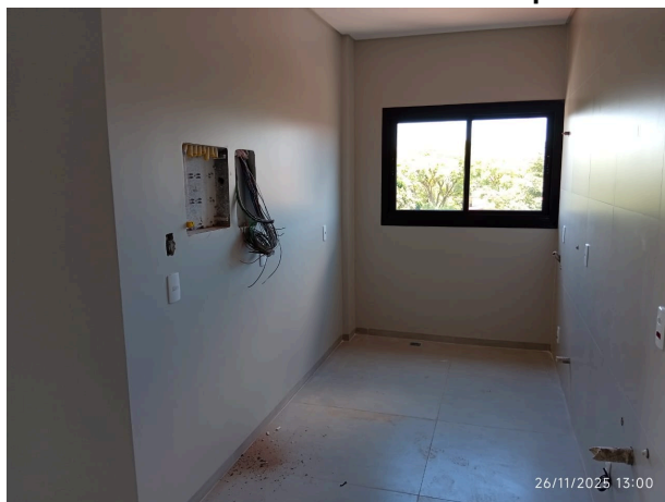
Foto 05 - Quadros elétricos incompletos
