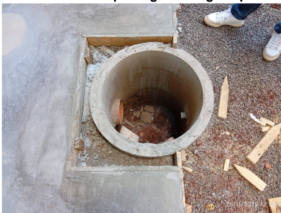
Foto 04 - Caixa de passagem de águas pluviais
