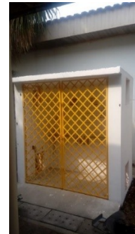
Adequação da casa de gases para instalação dos cromatógrafos
