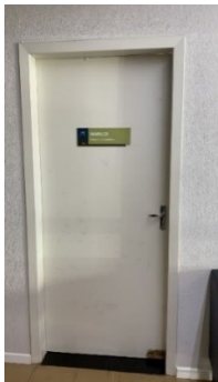
Entrada do laboratório de preparo
