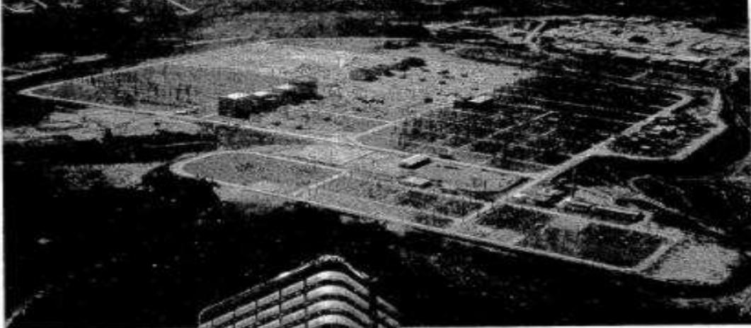
O Consórcio ASEA-PROMON está fornecendo para Furnas o maior sistema de transmissão em corrente contínua de alta tensão já instalado em todo o Mundo, o qual terá uma capacidade final de 6.300.000 quilowatts à tensão de + e - 600.000 volts, o que dá uma tensão entre polos de 1.200.000 volts.
